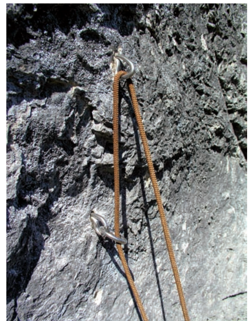
Zwei Verbundhaken übereinander bieten Redundanz beim Abseilen.
